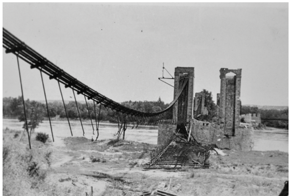
Pont de Beaucaire détruit par un bombardement en 1944 (Arch. Dép. Gard : 1367 W 49)
