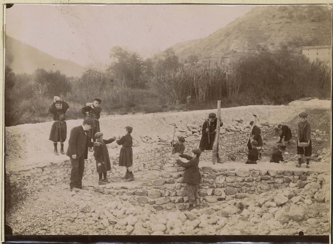
Construction d'une digue
